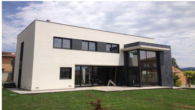
\***SATE** Es el mejor sistema de aislamiento en fachadas y le proporcionamos un acabado exterior con **mortero acrílico**, que le dota de cualidades hidrofugantes e impermeables al agua de lluvia y a la intemperie y permeable al vapor de condensación interior, permitiendo la transpiración del soporte.
