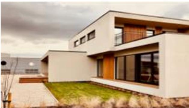
\***Mortero acrílico proyectado** (revestimiento sintético mineral multicapa, de altas prestaciones y elevado grado de dureza, para la decoración de todo tipo de fachadas en exteriores).
